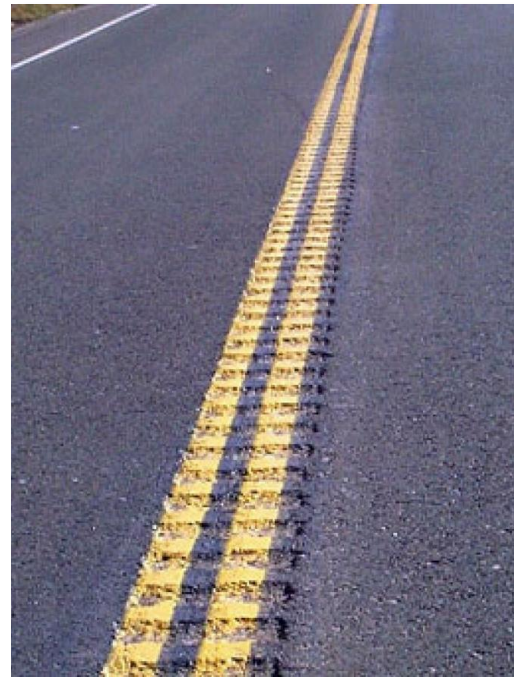
Longitudinal Rumble Strip on Centerline
